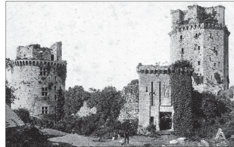
La tour Ronde, le châtelet et le donjon avant 1905
